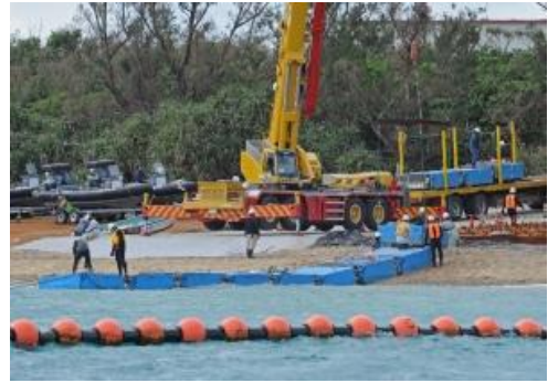
浮棧橋を再設置する作業員ら＝1月15日 名護市辺野古 沖縄タイムスより
